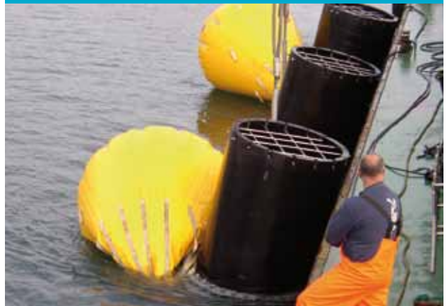
COLOCACIÓN DE DIFUSORES
