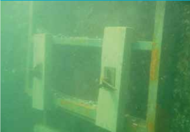
ENCOFRADO REPARACIÓN MUELLE
