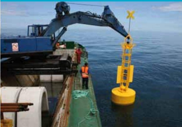
COLOCACIÓN DE BOYA
