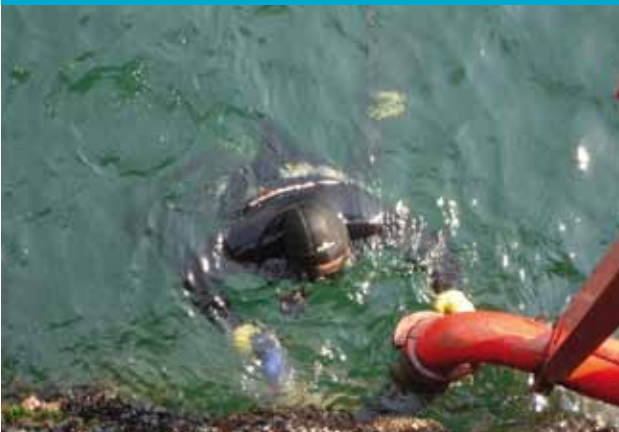
HORMIGONADO REPARACIÓN MUELLE
