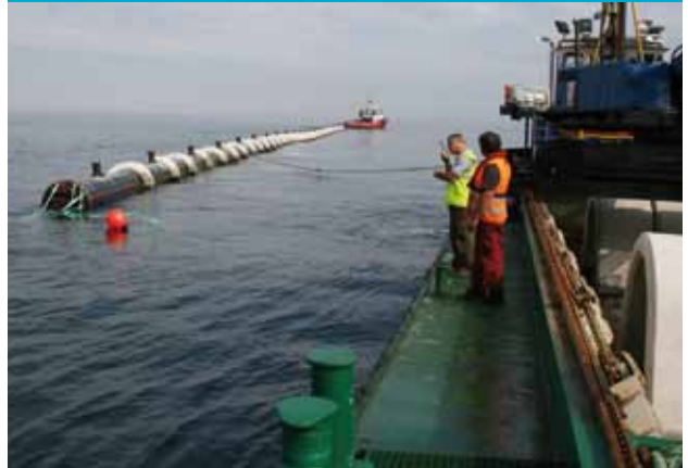
FONDEO TUBERÍA EMISARIO
