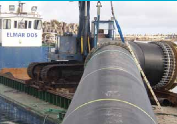
CONEXIONADO DE TUBERÍA
