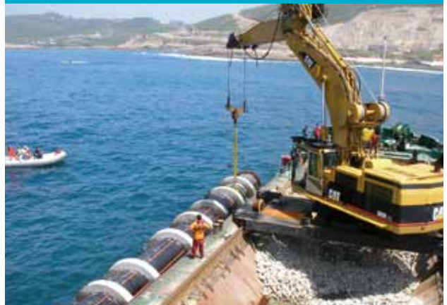
FONDEO DE TUBERÍA DE EMISARIO
