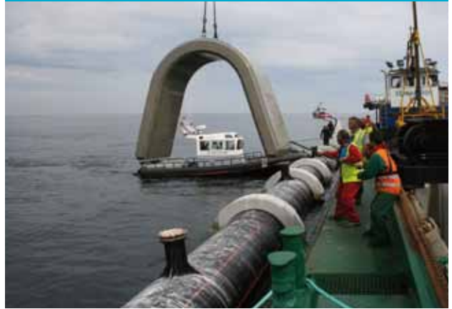
FONDEADO DE TUBERÍA
