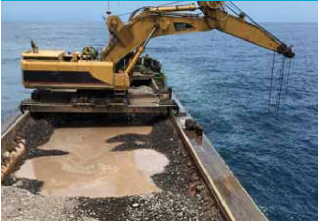
VERTIDO DESDE GRÚA PARA ENRASE
