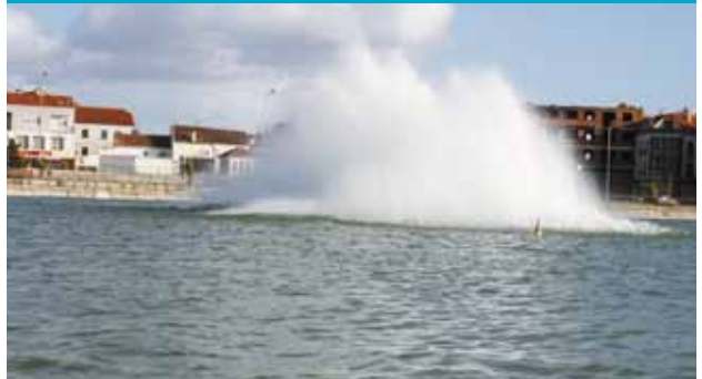
VOLADURA EN VILANOVA (PONTEVEDRA)
