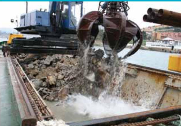
DRAGADO EN ROCA SAN VICENTE DE LA BARQUERA
