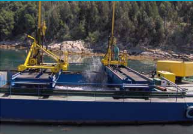
PERFORACIÓN PARA DRAGADO EN ROCA A LAGOA (VIGO)
