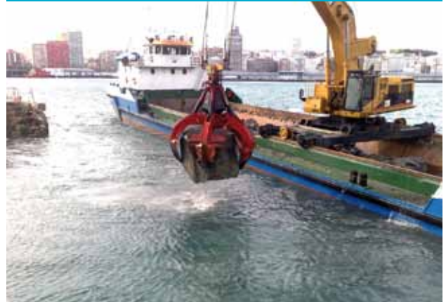
DRAGADO ESCOLLERA A CORUÑA
