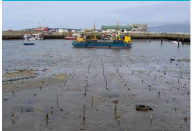
ENTUBADO DE PERFORACIÓN PARA VOLADURA
