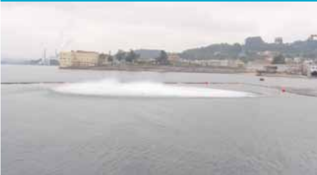
VOLADURA EN MARÍN (PONTEVEDRA)
