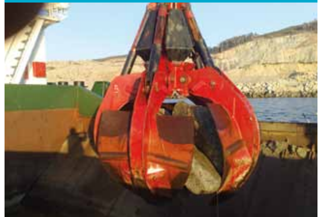
DRAGADO DE ROCA EN ZANJA
