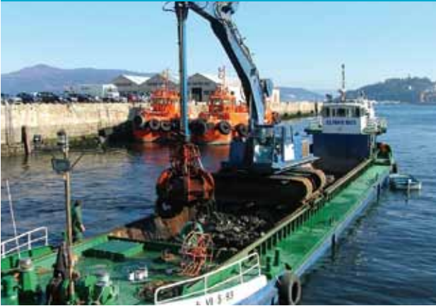
DRAGADO EN MATERIALES SUELTOS MUELLE PASAJE VIGO
