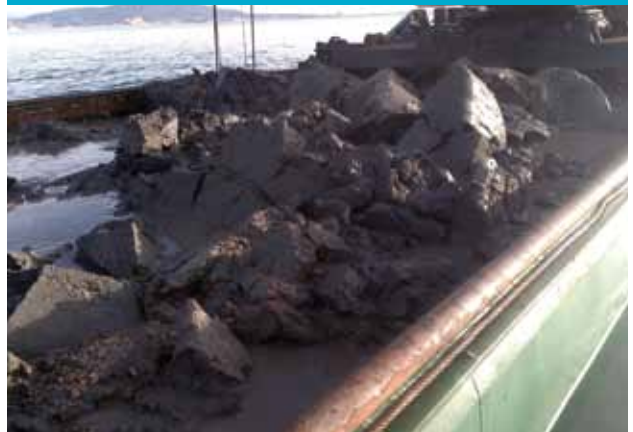
DRAGADO EN TERRENO ARCILLOSO FERROL
