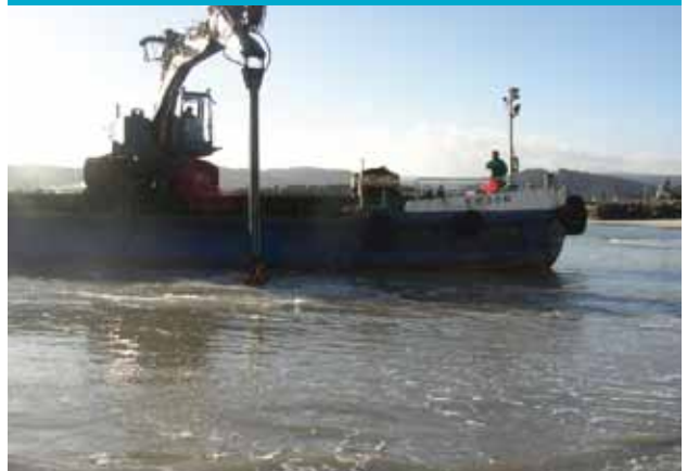
DRAGADO ARENA EN XOVE (LUGO)
