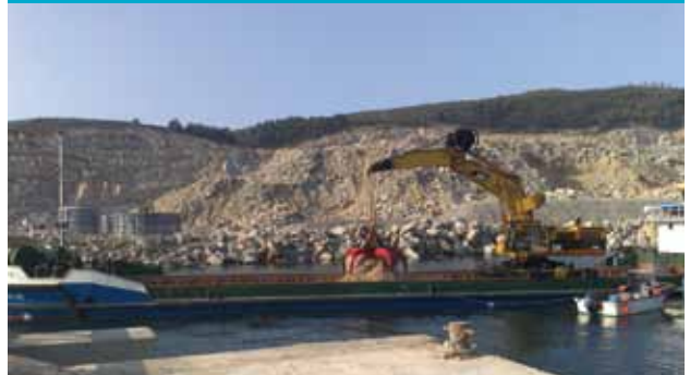
DRAGADO ARENA PUERTO EXTERIOR DE FERROL
